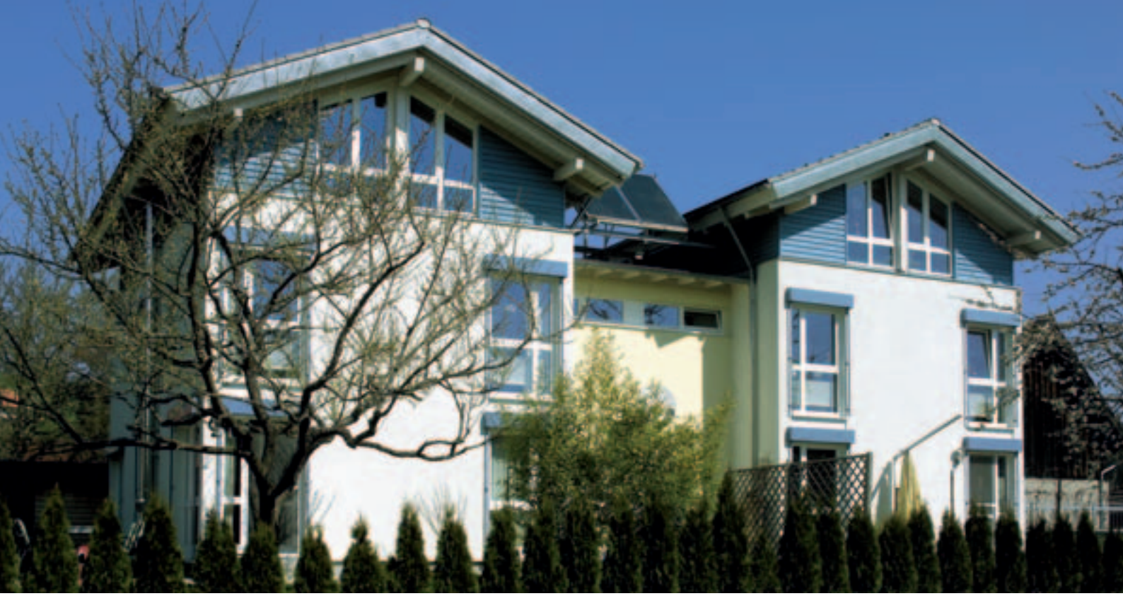
Wohnhaus Kuhfeld, Waldshut-Tiengen, Deutschland
