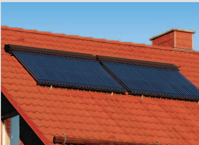
Vacuüm-buizen- collector volgens het heatpipe-principe
